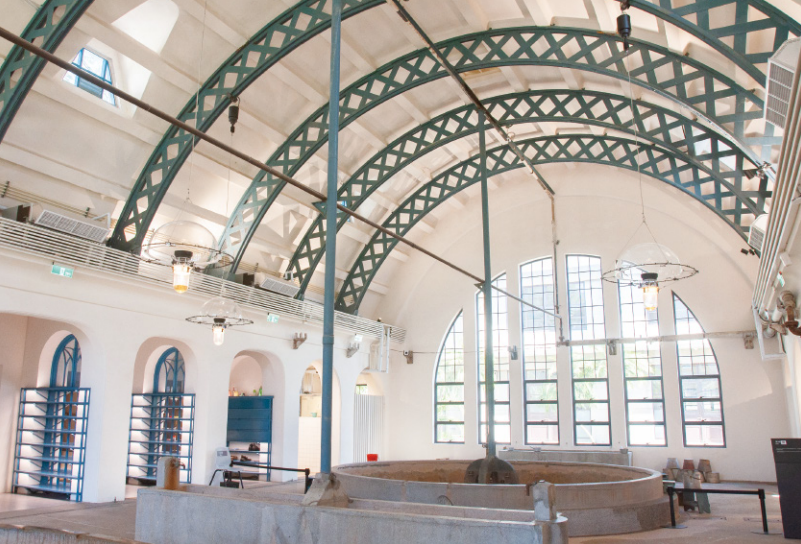
〈氫氫時代——員工澡堂常設展〉中央浴池區的圓弧屋頂鋼桁架結構是其特色（鐵博提供）
