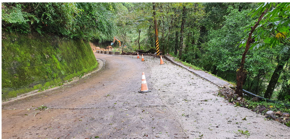
林道施工(新竹林管處提供)
