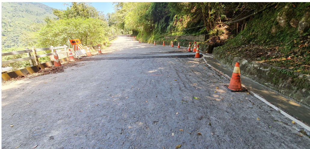
林道施工(新竹林管處提供)
