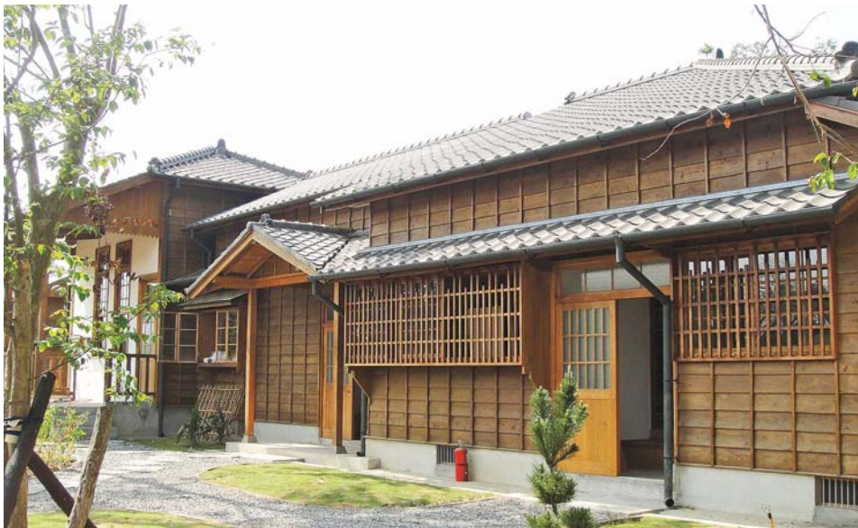
八田技師ら日本人職員が暮らした木造建ての宿舎
