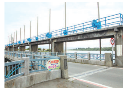
北端の清水大閘門
