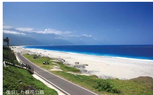
復旧した蘇花公路
