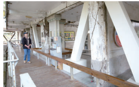
特殊な技術で補強された建物は見学可能
